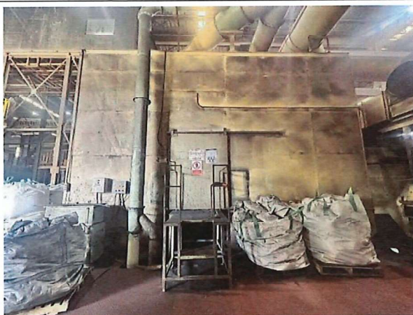
ภาพที่ 11 การติดตั้งเครื่องจักรภายในอาคารเพื่อป้องกันเสียง
