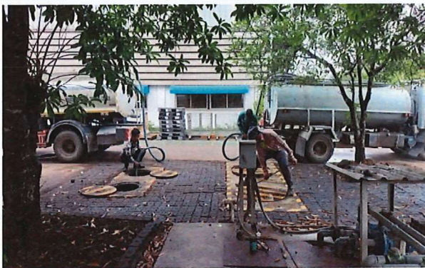
ภาพที่ 21 การดูแลทำความสะอาดถังบำบัดน้ำเสียสำเร็จรูป
