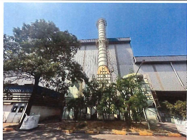
ภาพที่ 2 ปล่องระบบดักฝุ่นจากขั้นตอน Sand preparation (BH2)
