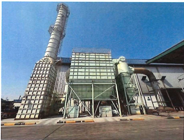
ภาพที่ 1 ปล่องระบบดักฝุ่นจาก Melting furnace (BH1)
